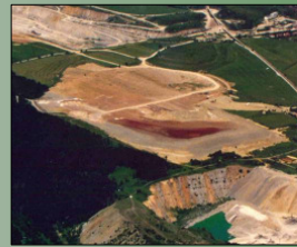
Spülhalde zu Beginn der Sanierung
