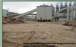
Baugrundabnahme am Standort eines Gaspuffers
