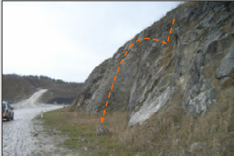
Kontrolle von Felsböschungen zur Bewertung der Steinfalgefahr an Fahrstraßen mit Lieferverkehr
